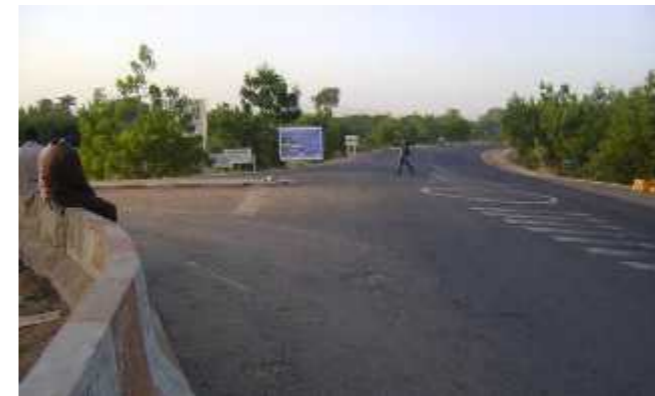
Pk 0 début du projet à l'entrée de la ville de Maroua juste après le Pont Makabaye sur le Mayo Tsanaga
