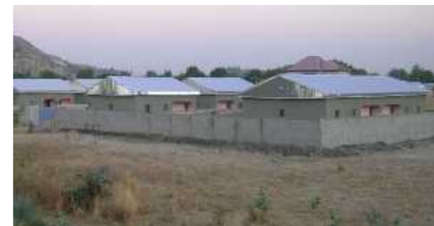
Construction d'une cité d'hébergement
