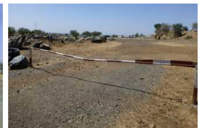
Sécurisation de l'entrée du site
